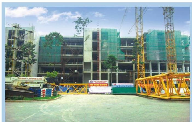
Lắp hệ thống điện Nhà Quốc Hội Installation of power system for National Assembly House
