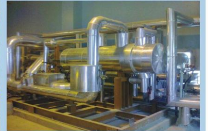
Lắp đặt, bảo ôn hệ thống ống công nghệ Nhà máy Nhiệt điện Nghi Sơn 1 Installation of equipments for Nghi Son 1 Thermal Power Plant
