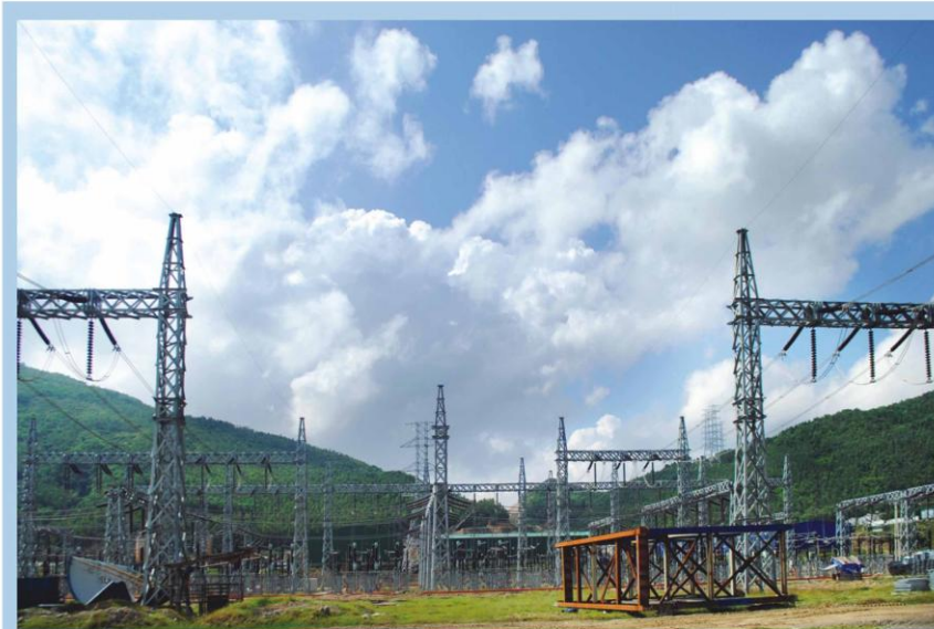
Lắp trạm điện thuộc Nhà máy Nhiệt điện Vũng Áng 1 Installation of transformer station for Vung Ang 1 Thermal power plant
